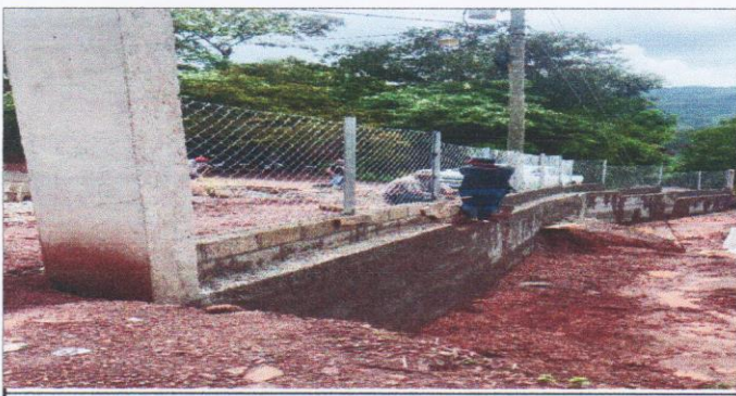
Foto 5: Colocacion de malla galvanizada.
