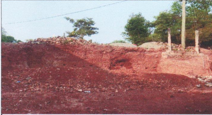
Foto 1: inicio de trabajos en muro perimetral
