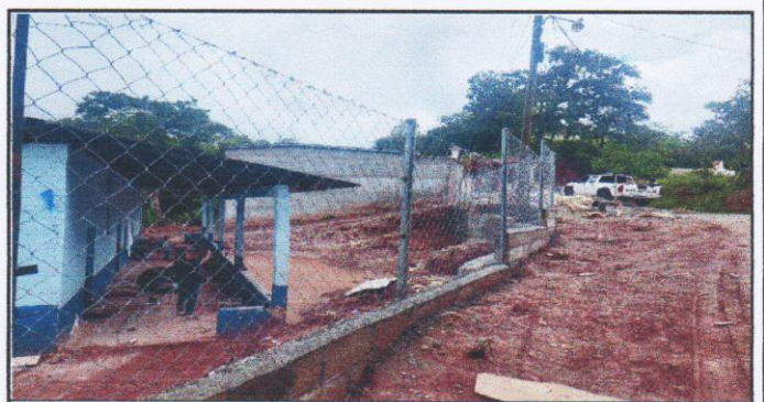
Foto 6: colocacion de maya galvanizada.
