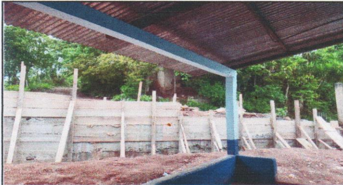
Foto 3: fundicion de muro de contencion.
