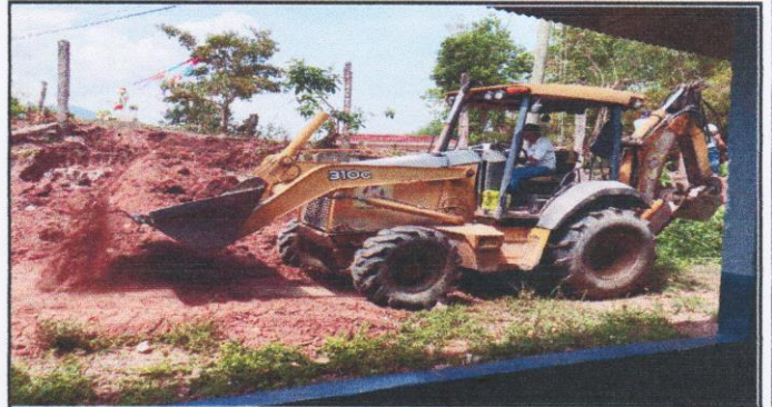
Foto 2: inicio de trabajos con maquinaria pesada en muro perimetral
