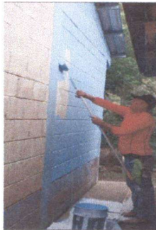
Foto 3: Pintura en muro exterior
