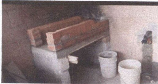
Foto 7: reparación de cocina
