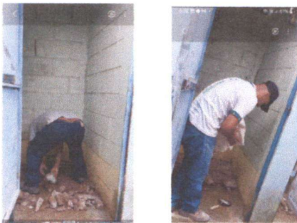
Foto 5: sustitución de servicios sanitarios
