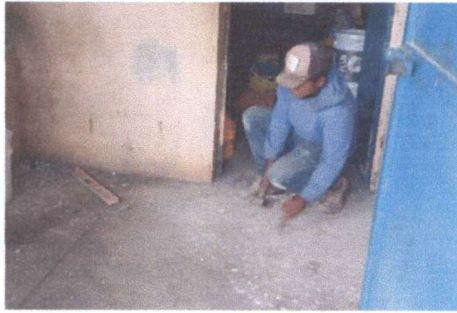
Foto1: sustitución de piso cocina
