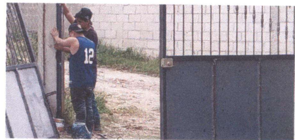
Foto 10: Sustitución de portón
