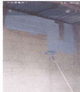
Foto 4: pintura en muro interior
