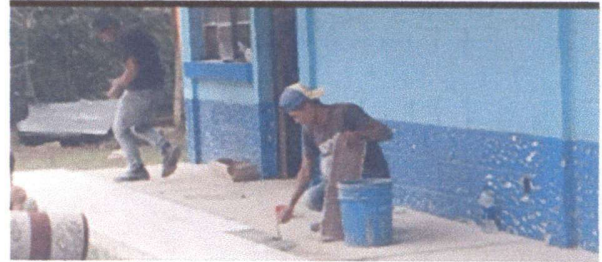
Foto 2: Sustitución de piso en corredor y socalo
