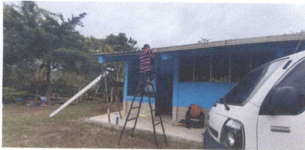
foto 9: sustitución de canal de agua pluvial.
