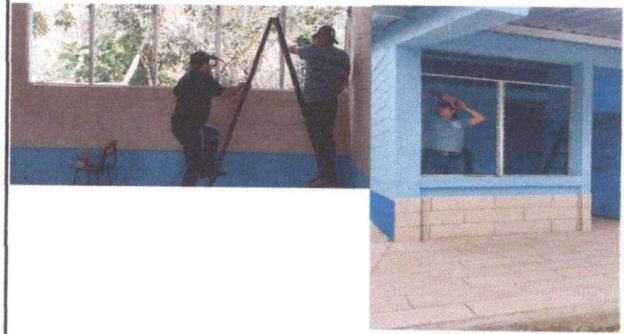
Foto 8: Sustitución de ventanas por PVC
