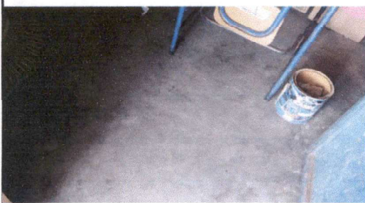
Foto 5: sustitución de piso cocina y bodega
