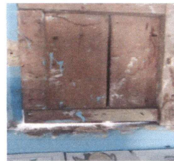
Foto 4: sustitución de ventanas
