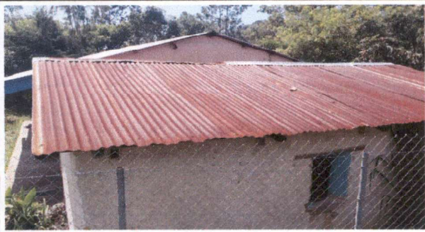
Foto1: sustitución de lámina por lámina troquelada
