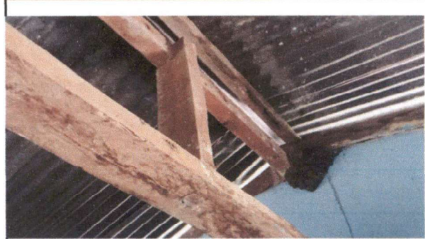
Foto 2: Sustitución de soporte de madera por metal
