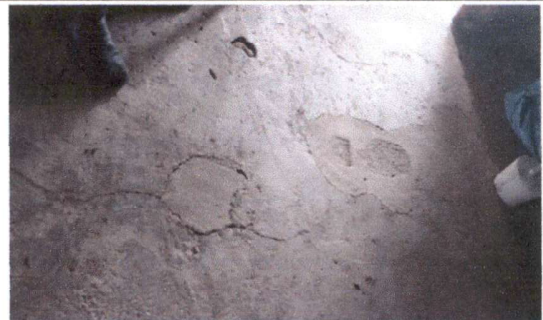
foto 6: sustitución de piso en corredor y salón 2
