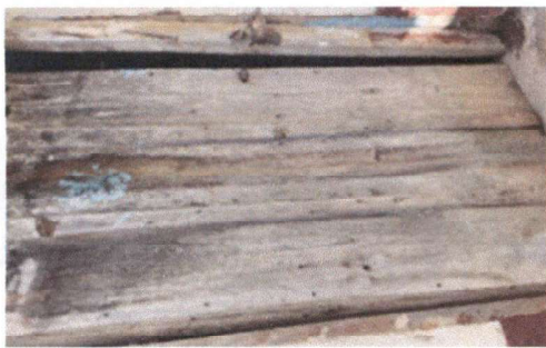
foto 3: sustitución de puertas
