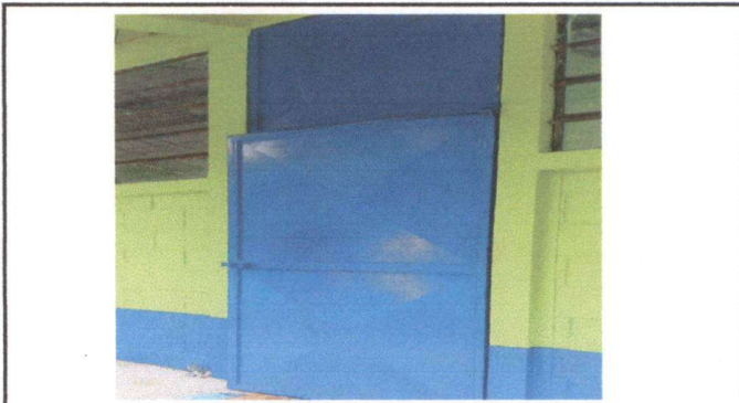
Foto 4: Mantenimiento de puertas
