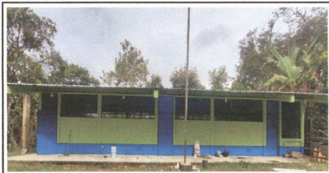
Foto 6: Reparación de pintura de paredes
