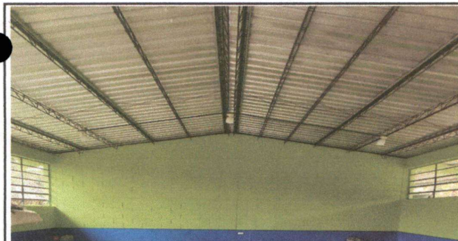
Foto 5: Reparación de pintura de paredes
