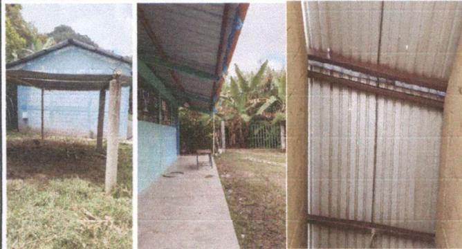
Foto 1: Sustitución de lamina y canales
