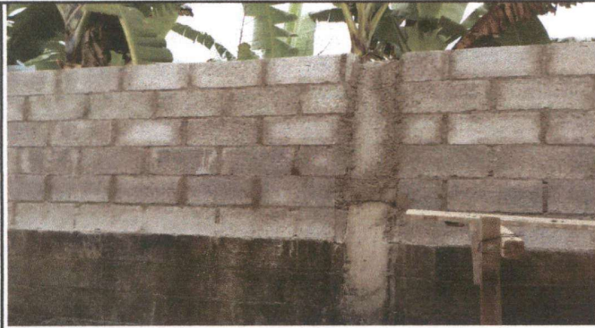
Foto 1: Mejoramiento de muro perimetral
