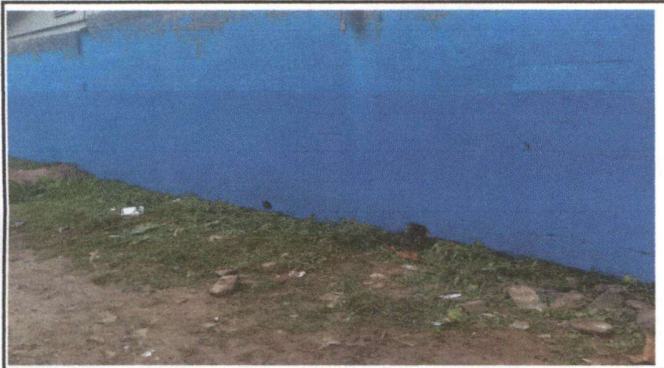
Foto 3: Pintura de muro
