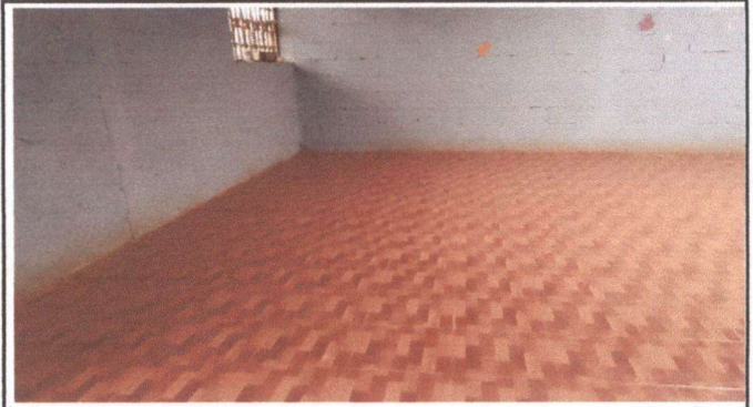
Foto 2: sustitucion de piso
