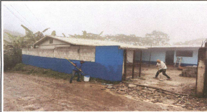
Foto 3: Pintura de muro
