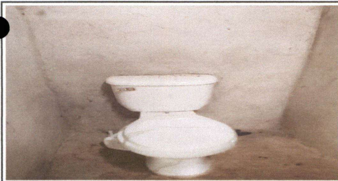
Foto 5: Mejoramiento de servicios sanitarios
