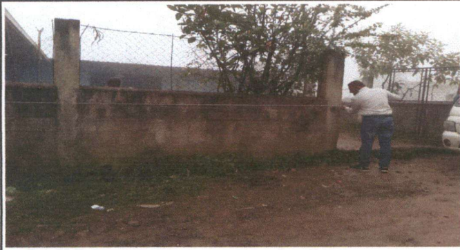
Foto 1: Mejoramiento de muro perimetral
