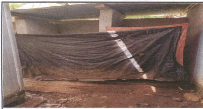
Foto 5: Mejoramiento de servicios sanitarios
