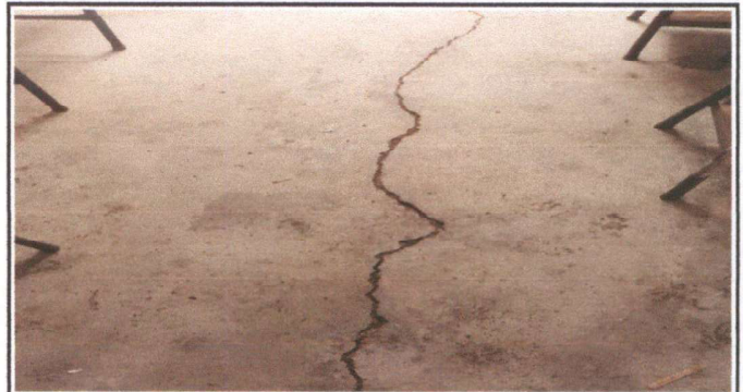
Foto 2: sustitucion de piso
