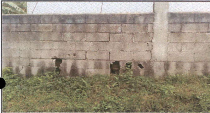
Foto 1: Mejoramiento de muro perimetral
