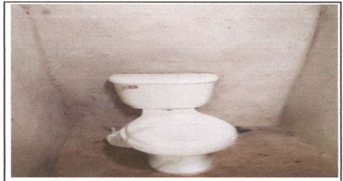
Foto 4: Mejoramiento de servicios sanitarios
