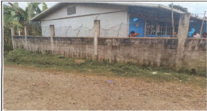
Foto 3: Pintura de muro
