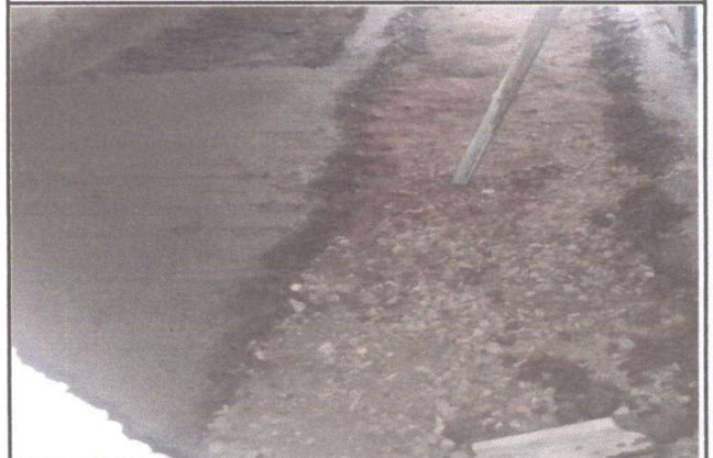
Foto 4: losa de patio
