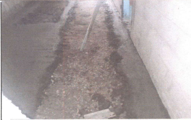
Foto 1: Cambio de piso, entortado remolineado semiliso
