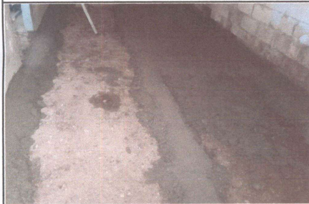
Foto 3: Cambio de piso, entortado remolineado semiliso.
