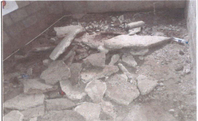
Foto 2: Cambio de piso, entortado remolineado semiliso.
