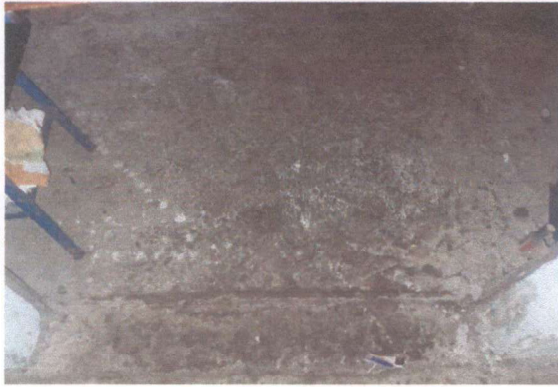
Foto 1: Cambio de piso, entortado remolineado semiliso
