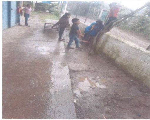
Foto 4: losa de patio
