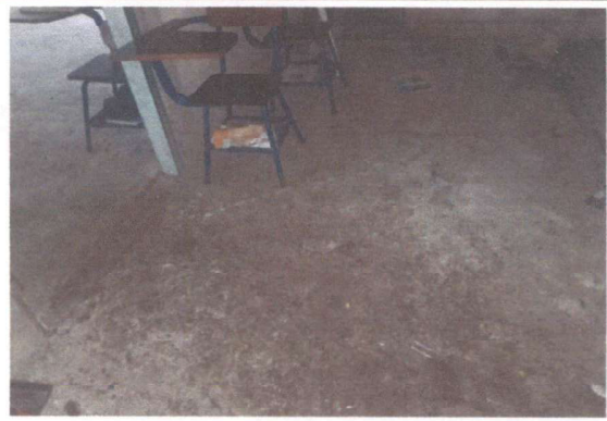
Foto 2: Cambio de piso, entortado remolineado semiliso.
