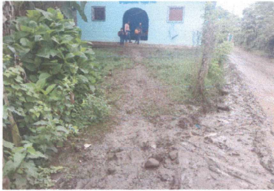
Foto 1: continuación de muro perimetral.
