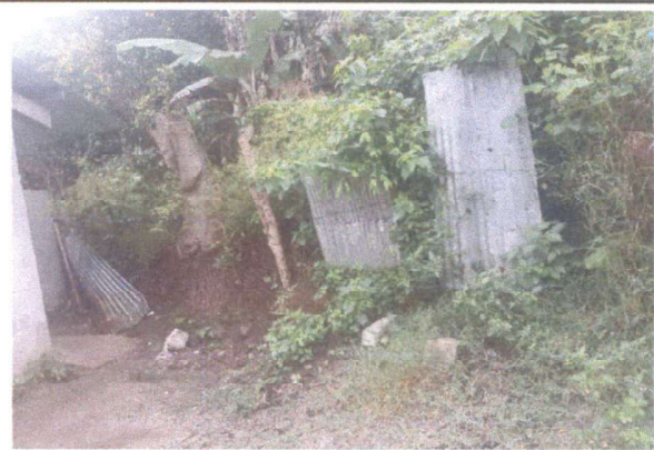
Foto 4: Continuación de Muro Perimetral
