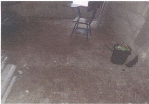
Foto 3: Cambio de piso, entortado remolineado semiliso.
