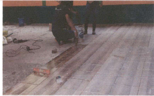
Foto 2: SUSTITUCIÓN DE PISO DE CONCRETO POR PISO CERÁMICO
