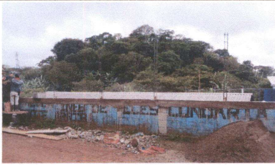
Foto 1: SUSTITUCIÓN DE MURO PERIMETRAL.
