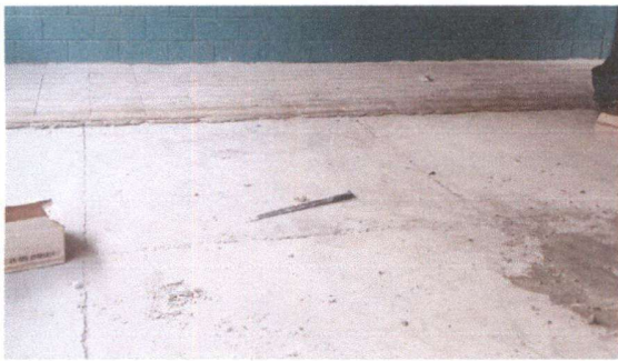
Foto 3: SUSTITUCIÓN DE PISO DE CONCRETO POR PISO CERÁMICO
