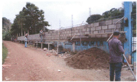
Foto 2: SUSTITUCIÓN DE MURO PERIMETRAL.
