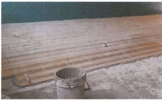
Foto1: SUSTITUCIÓN DE PISO DE CONCRETO POR PISO CERÁMICO
