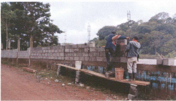
Foto 3: SUSTITUCIÓN DE MURO PERIMETRAL.
