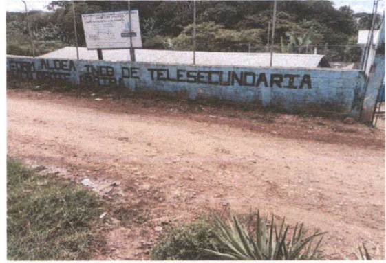
Foto 2: Completación de muro perimetral
