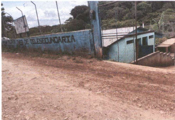
Foto 1: Completación de muro perimetral
