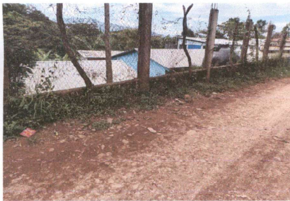
Foto 3: Completación de muro perimetral
