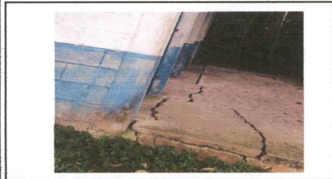
Foto 3: Reparación de piso en área de baños.
