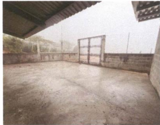
Foto 4: reparación de planchas de concreto de patio
