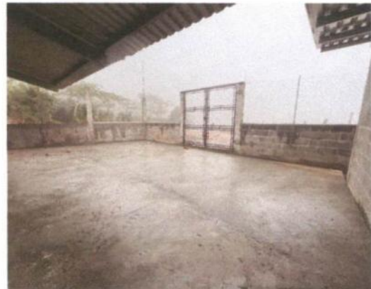
Foto 4: reparación de planchas de concreto de patio
