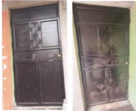
Foto 2: sustitución de puertas de lámina y madera por metal
