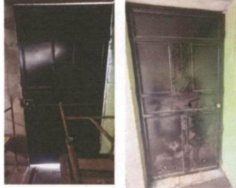
**Foto 2: sustitución de puertas de lámina y madera por metal**
