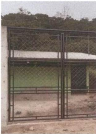
**Foto 3: sustitución de portón de madera y alambre por portón de malla y tubo galvanizado**
