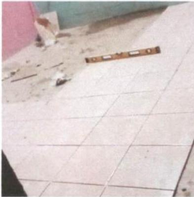
**Foto 7: Sustitución de piso de concreto por cerámico**
