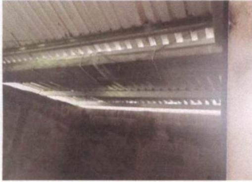
**Foto 5: sustitución de estructura soporte de madera por metal, Sustitución de lámina, por lámina troquelada aluzinc calibre 26.**
