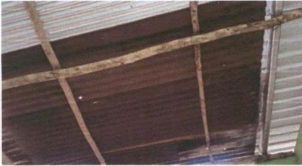
Foto 5: sustitución de estructura soporte de madera por metal, Sustitución de lámina, por lámina troquelada aluzinc calibre 26.
