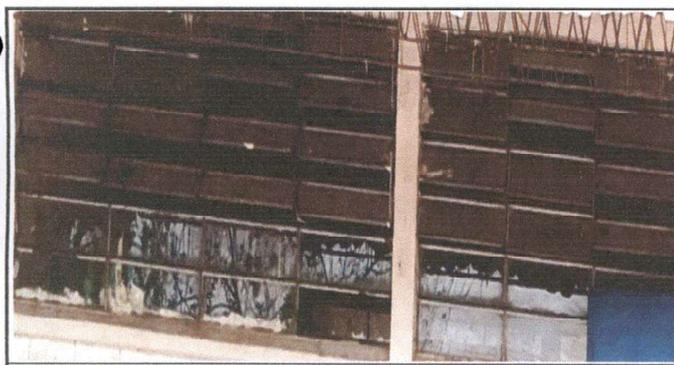
Foto 5: Sustitución de ventanales de vidrio por balcones de metal
