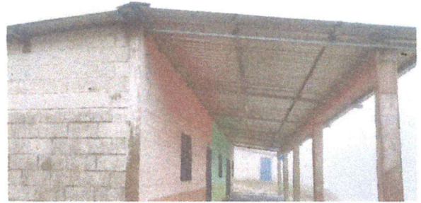
Foto 2: sustitución de lámina y madera
