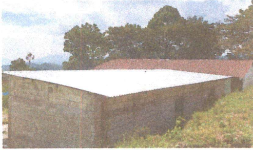
Foto 1: Sustrucción de Lámina y estructura
