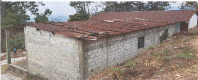
Foto 1: Sustrucción de Lámina
