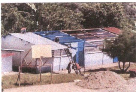
Foto 1: Cambio del Techo en mal Estado y Losa de Patio
