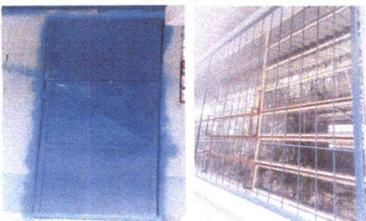
Foto 3: Lijado y pintado de Puertas y Balcones en mal Estado
