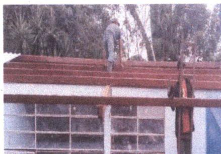
Foto 2: Mantenimiento de Estructura de techo y quitado de Láminas en mal Estado
