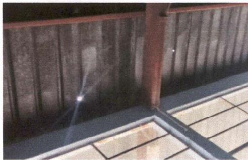
Foto 2: Estructura de techo y Láminas en mal Estado
