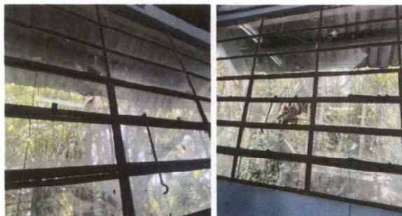
Foto 4: Ventanas y Vidrios en mal Estado
