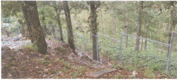
Foto 1: SUSTITUCION DE CERCO DE ALAMBRE POR MALLA Y TUBO
