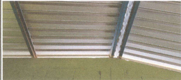
Foto 4: SUSTITUCION DE LAMINA EN DOS AULAS
