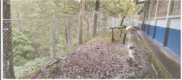
Foto 2: SUSTITUCION DE CERCO DE ALAMBRE POR MALLA Y TUBO
