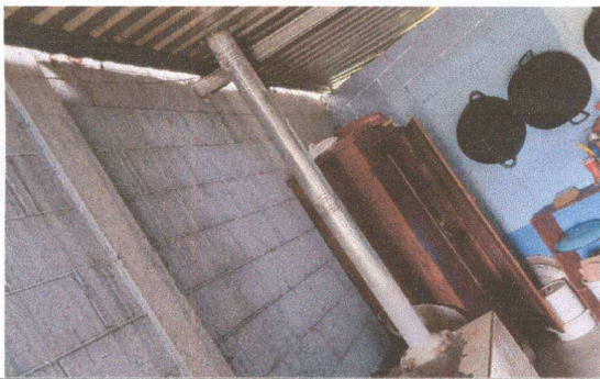
Foto 3: SUSTITUCION DE CHIMINEA EN MAL ESTADO
