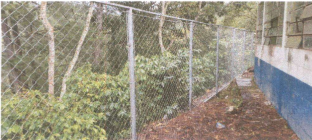
Foto 3: SUSTITUCION DE CERCO DE ALAMBRE POR MALLA Y TUBO
