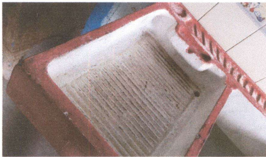
Foto 5: SUSTITUCION DE PILA
