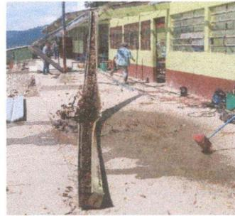
Foto 2: SUSTITUCION DE CANAL EN MAL ESTADO
