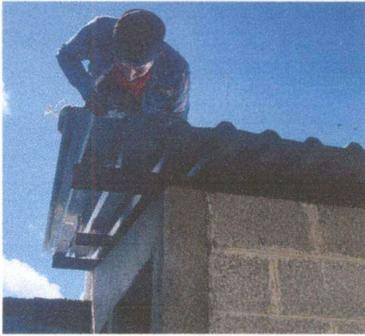
Foto1: SUSTITUCION DE LAMINA DE BAÑO
