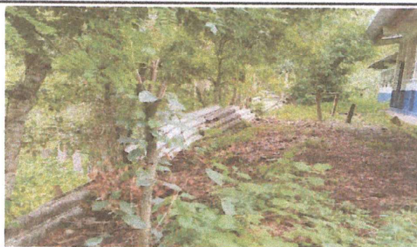
Foto 2: SUSTITUCION DE CERCO DE ALAMBRE POR MALLA
