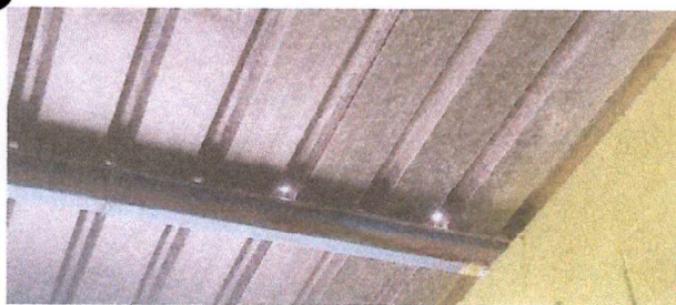
Foto 5: SUSTITUCION DE LAMINA DE DOS AULAS
