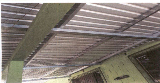
Foto 3: sustitución de canaletas de metal
