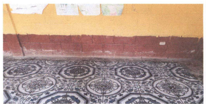
Foto 4: sustitución de piso
