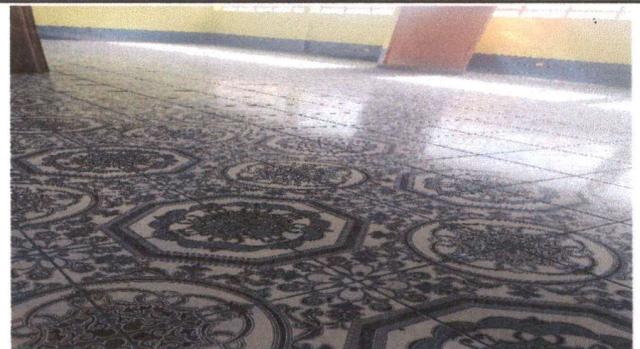
Foto 6: Sustitución de piso.
