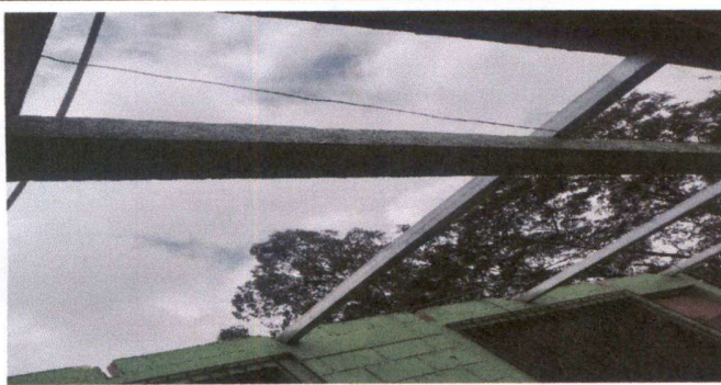
Foto 3: sustitución de canaletas de metal
