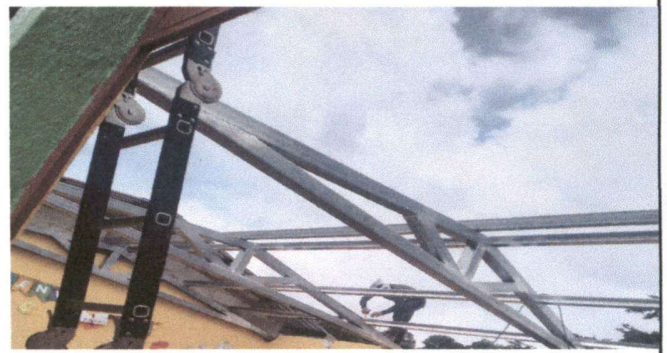
Foto 2: sustitución de madera por metal
