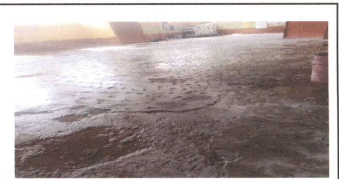
Foto 6: sustitución de piso.
