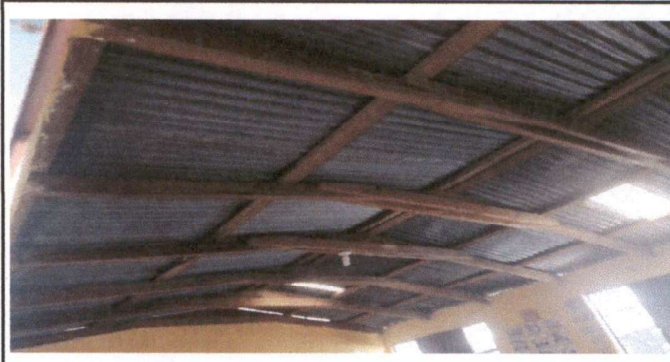
Foto 2: sustitución de madera por metal
