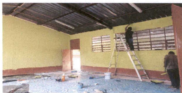
Foto 6: Pintura en paredes.
