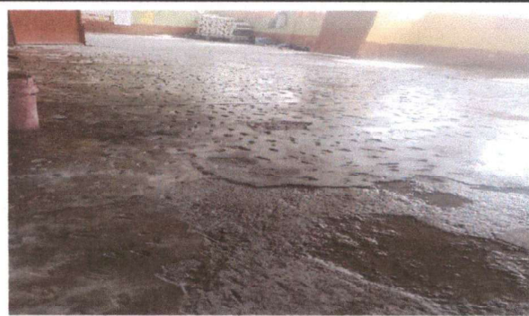
Foto 4: sustitución de piso
