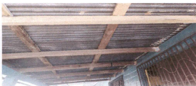
Foto 5: Sustitución de costaneras de madera por metal.
