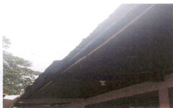
Foto 3: sustitución de canaletas de metal
