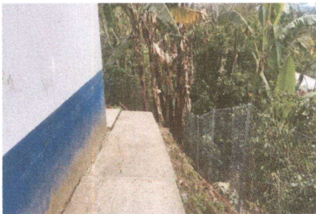
Foto 5: Sustitución de serco por tela malla con alambre de púas y tubo galvanizado
