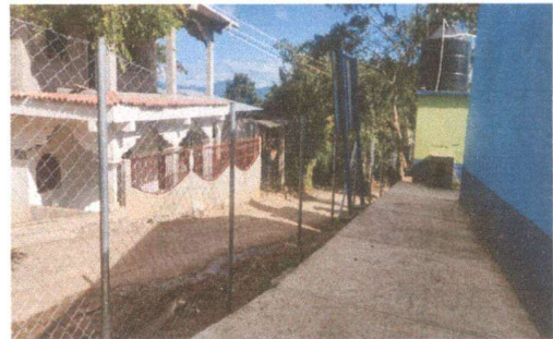
Foto 6: Sustitución de serco por tela malla con alambre de púas y tubo galvanizado
