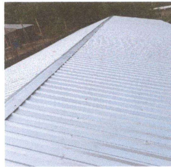
Foto 4: Sustitución cubierta de lámina
