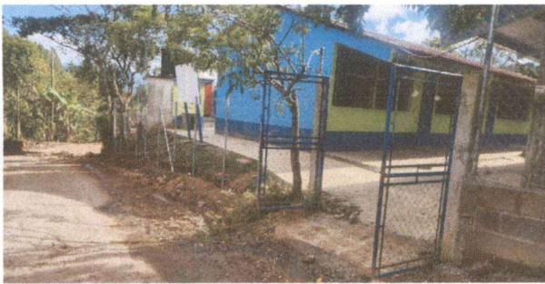
Foto 3: Sustitución de serco por tela malla con alambre de púas y tubo galvanizado
