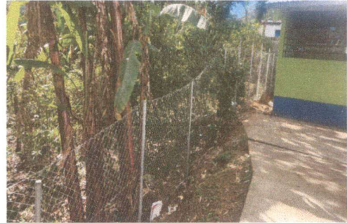
Foto 2: Instalación de malla con alambre de púas y tubo galvanizado
