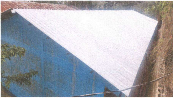
Foto1: Sustitución cubierta de lámina
