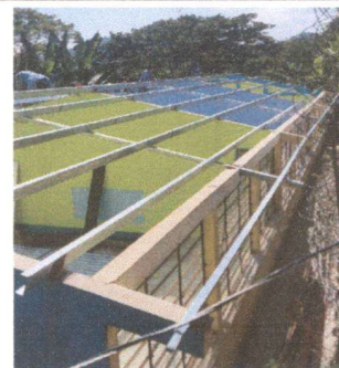
Foto 4: Sustitución de estructura metálica
