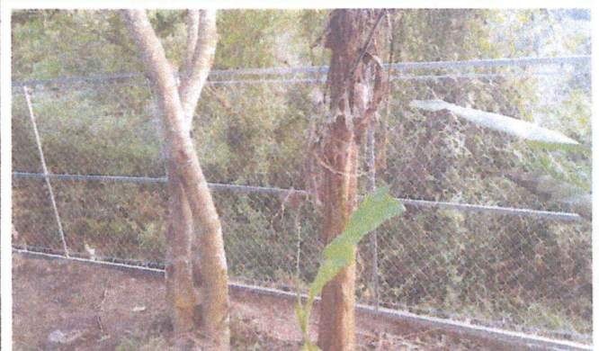
Foto 2: Reparación de circulado de block y malla.
