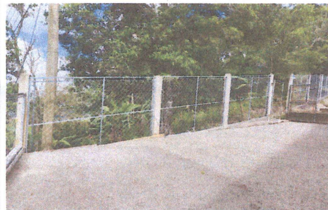
Foto 3: Remodelación de Rampa
