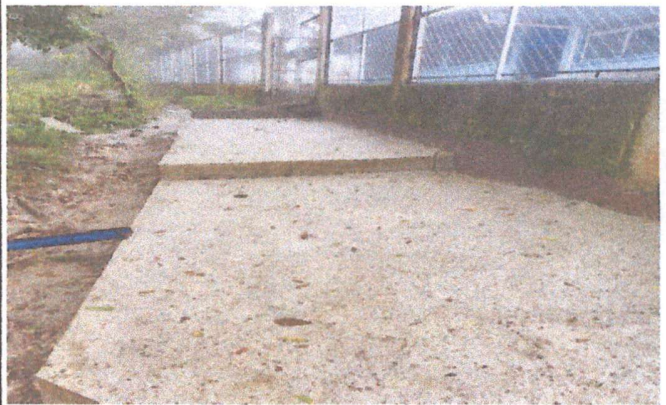
Foto 4: Reparación de arriete
