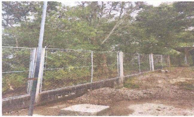
Foto 1: Reparación de circulado de block y malla.
