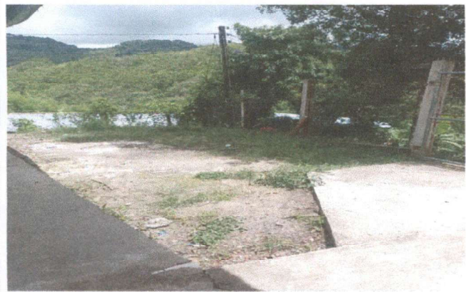
Foto 3: Remodelación de Rampa
