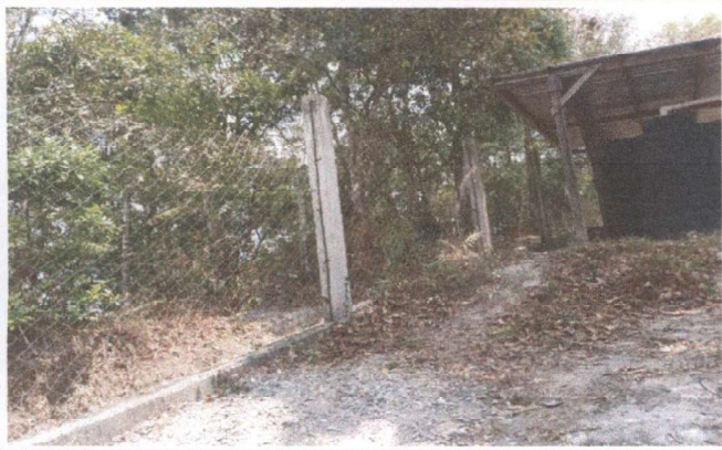
Foto 1: Reparación de circulado de block y malla.
