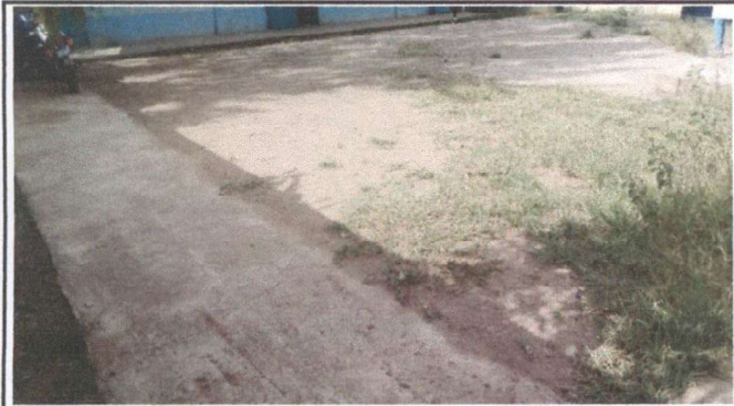
Foto 1: Losa de patio (reparación de plancha de concreto de patio).
