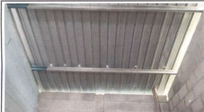
Foto 3: Cocina (Cambio de techo)
