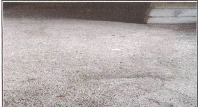
Foto 4: Cocina (Instalación de piso cerámico).
