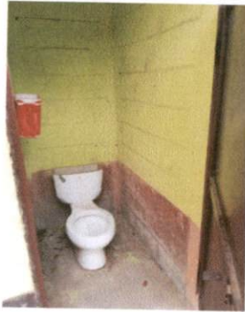
Foto 7: Sustrucción de inodoros
