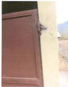
Foto 3: Pintura y reparación de puertas
