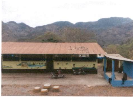
Foto 1: Pintura de cubierta de techado y lámina.
