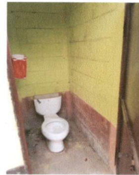
Foto 4: Sustitución de torta de cemento por piso antideslizante.
