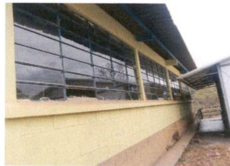
Foto 6: Pintura en muros interior y exterior.
