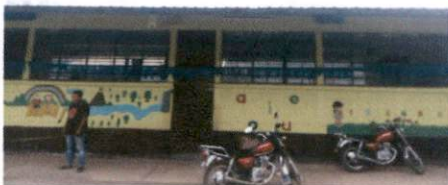
Foto 5: Sustitución de canales de metal.
