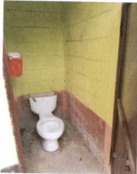
Foto 9: Reparación o sustrucción de azulejo.
