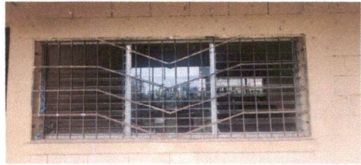
Foto 2: Instalación de ventanas corredizas.
