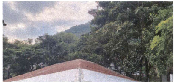
Foto 6: Sustitución de láminas dañadas.
