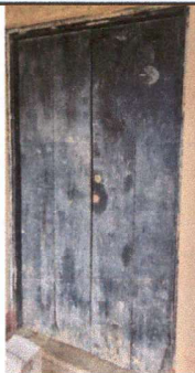
Foto 5: Reforzamiento de puertas.
