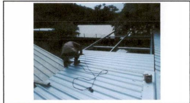
Foto 2: Cubierta de lámina
