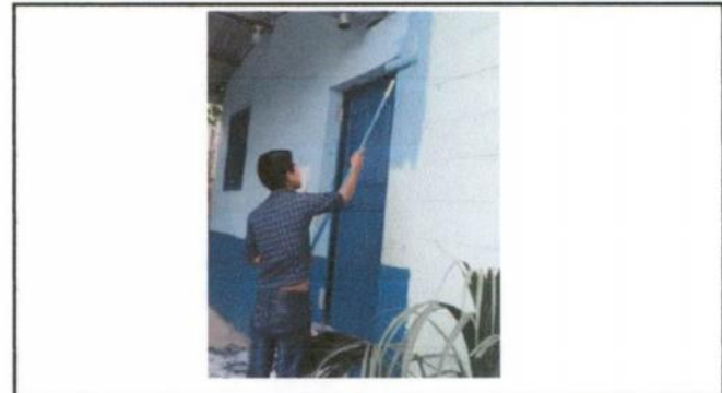
Foto 4: Pintura interior y exterior
