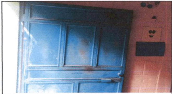
Foto 3: Reparación de puerta
