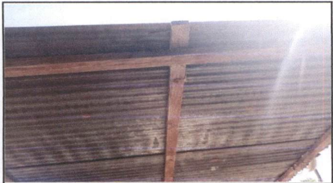
Foto 1: Sustrución de cubierta de lámina
