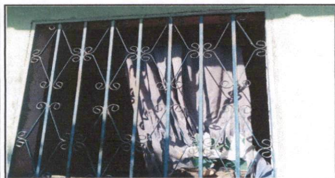
Foto 5: Intalación de ventana de metal
