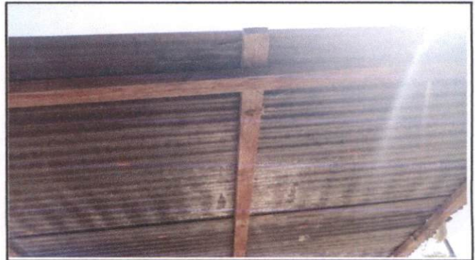
Foto 2: Sustrución de estructura de techo
