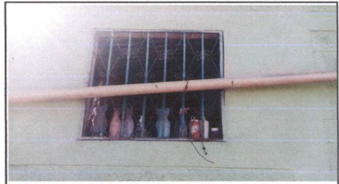
Foto 4: Reparacion ed baja de agua pluvial
