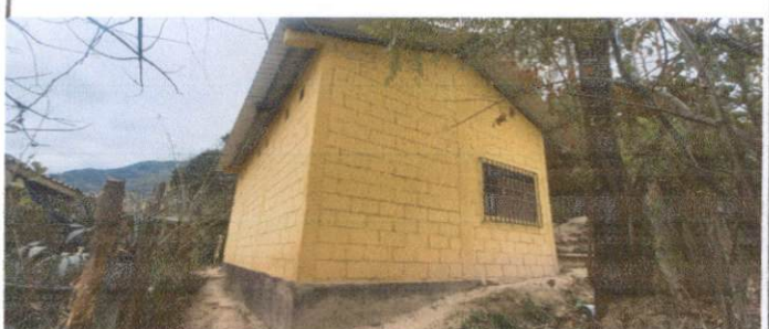
Foto 4: Pintura en muros interiores y exteriores.
