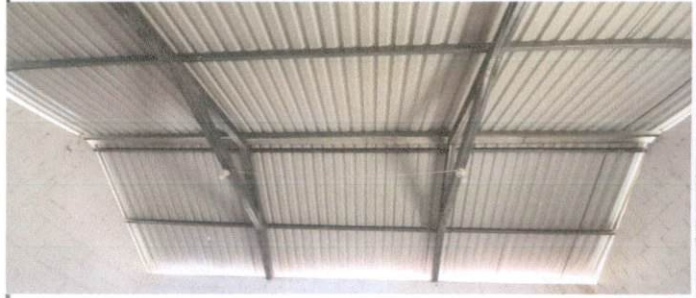
Foto 2: Estructura de techo: sustitución de estructura metálica.
