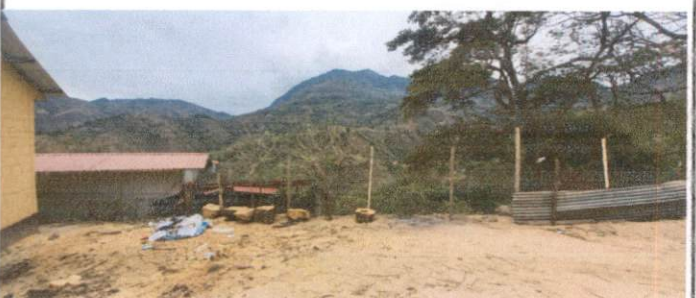
Foto 5: Cerco o muro perimetral de block y malla.
