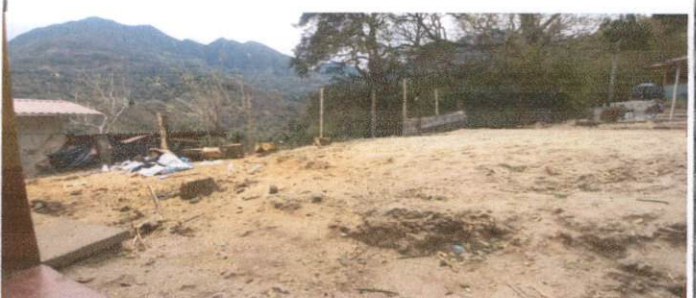
Foto 6: Reparación de planchas de concreto de patio.
