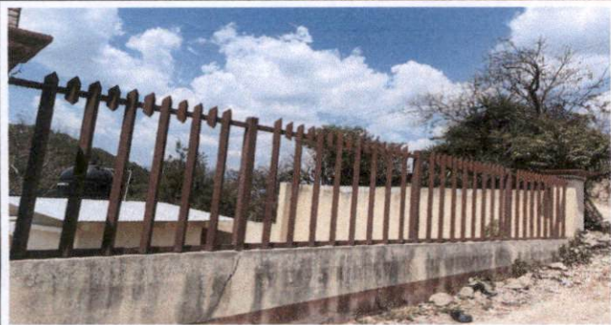
Foto 13: reparación y pintura de barandal del frente 17 metros lineales
