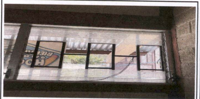
Foto 6: colocación de 8 paletas de vidrio
