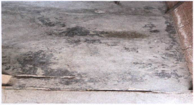
Foto 7 : sustitución de piso de concreto a piso de granito de 2 aulas
