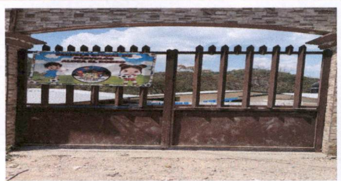
Foto 14: mantenimiento a porton de metal
