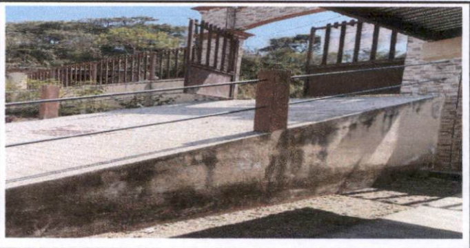
Foto 12: reparación de barandal de entrada con barrilla lisa y pintura para evitar peligro de los niños
