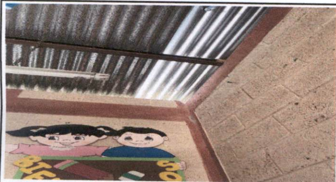
Foto 3: Sustitución de estructura de soporte de metal por metal galvanizado
