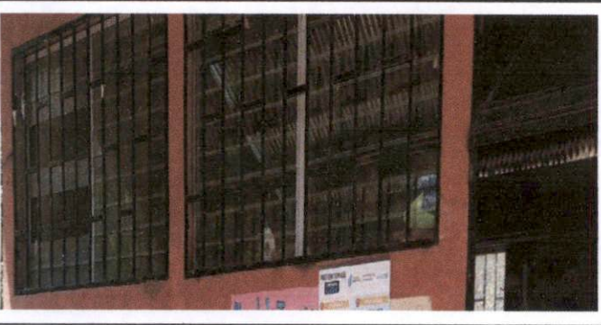
Foto 11: pintura a 4 balcones de baranda
