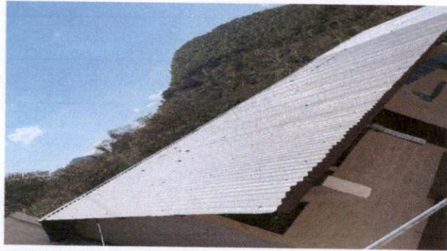
Foto 1: sustitucion de cubierta de lamina de 2 aulas por lamina troquelada
