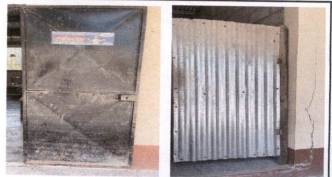
Foto 4: Mantenimiento de estructura y pintura de 5 puertas y sustitución de puerta de lamina a puerta de metal legítimo
