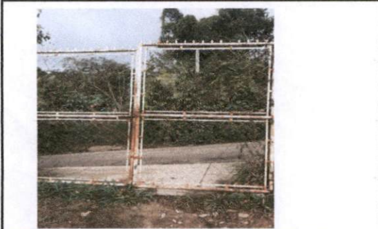
Foto 7: Mantenimiento a portón del establecimiento
