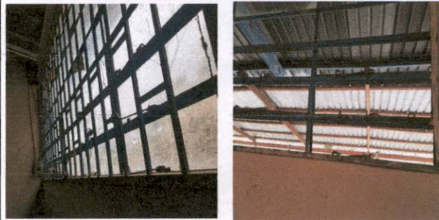
Foto 6: Sustitución de balcones deteriorados
