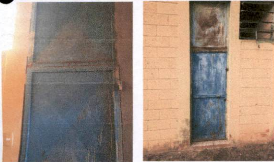
Foto 3: Mantenimiento y sustitución a puertas deterioradas
