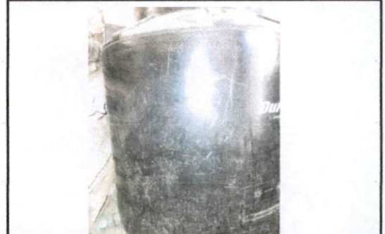
Foto 8: Sustitución de tinaco recolector de agua
