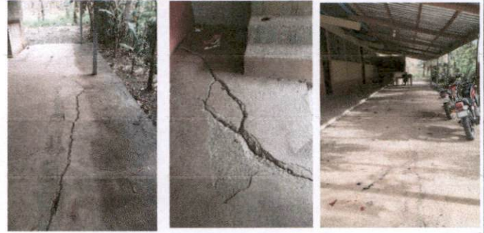
Foto 4: Sustitución de piso de concreto de semento deteriorado
