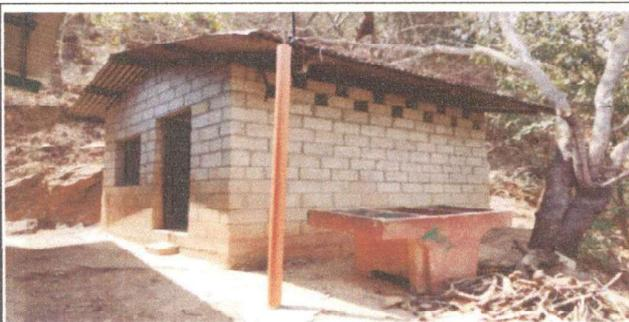
Foto 5: Techado con lamina troquelada y estructura
