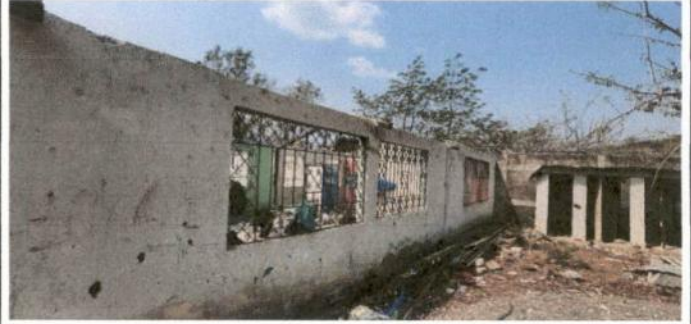
Foto 2: Reparación de paredes en mal estado.
