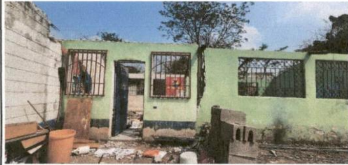
Foto 1: Reparando paredes de aulas y columnas en mal estado.
