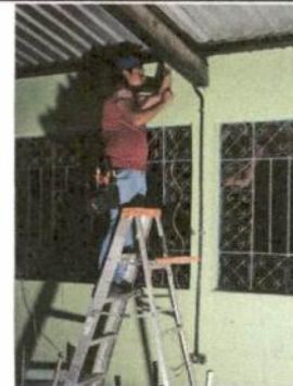
Foto 6: Reparación de cableado eléctrico.
