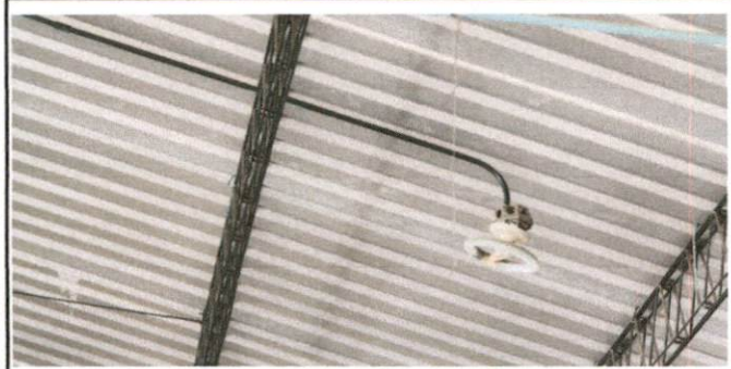
Foto 7: Lámparas y plafoneras en mal estado, necesitan sustitución.
