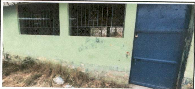
Foto 4: Reparación y mantenimiento de puerta.
