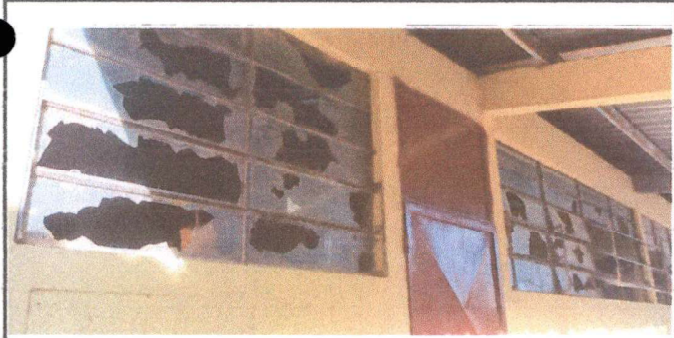
Foto 5: Sustitución de vidrios en mal estado.
