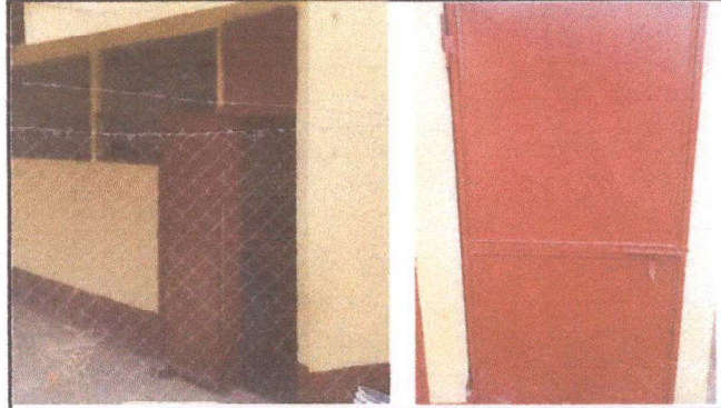
Foto 8: Mantenimiento y pintura de puertas.
