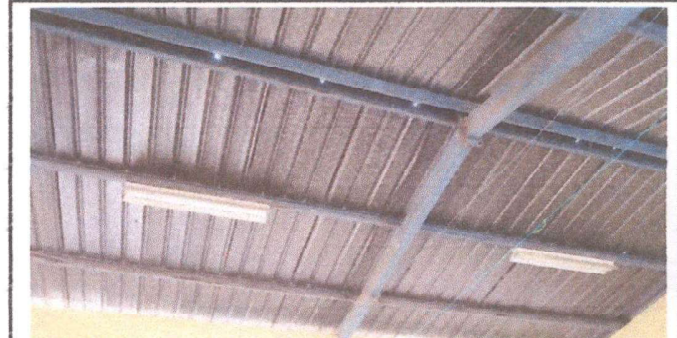
Foto 6: Reparación del sistema eléctrico.
