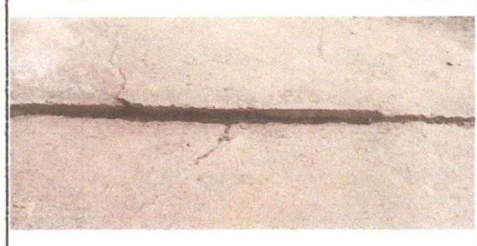
Foto 2: Reparación de losa de patio.
