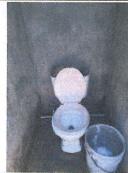
Foto 2: Mantenimiento y sustitución de sanitarios en mal estado.
