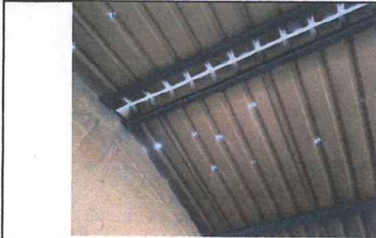
Foto 1: Sustrucción de lámina.
