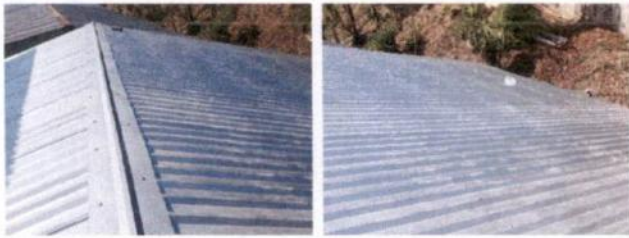
Foto1: pintura de costanera y sustitución de lámina por lámina roquelada
