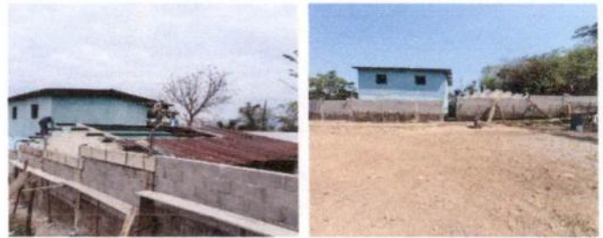
Foto 4: ampliación de muro perimetral de block
