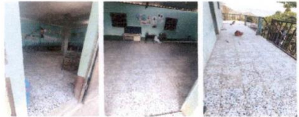
Foto 2: sustitución de torta de cemento a piso de granito
