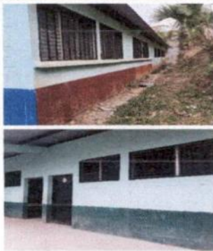
Foto 3: Colocación de balcones
