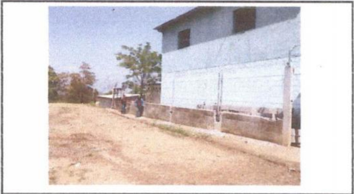
Foto 4: ampliación de muro perimetral de block
