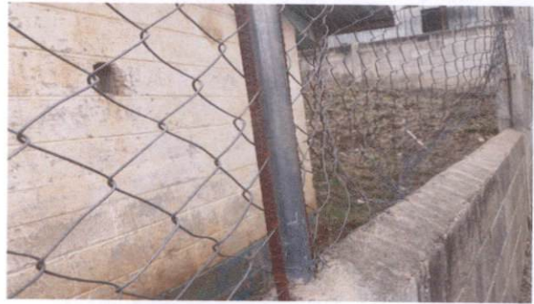
Foto 4. Ampliación de muro perimetral de block.
