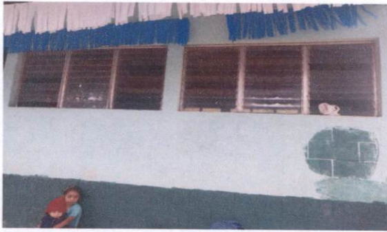
Foto 3. Colocación de balcones.
