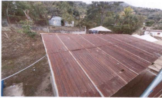
Foto 1. Sustitución de lámina, por lámina troquelada.
