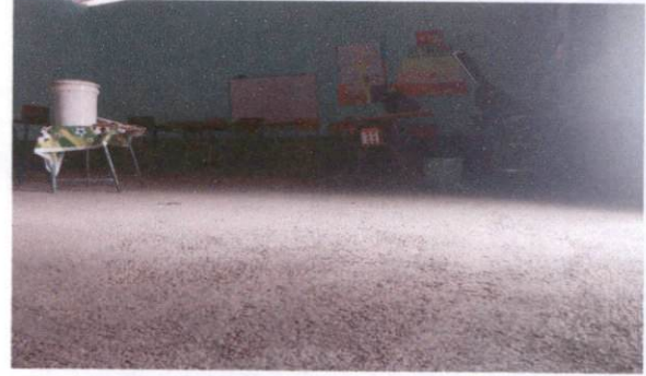
Foto 2. Sustitución de torta de cemento a piso de granito.
