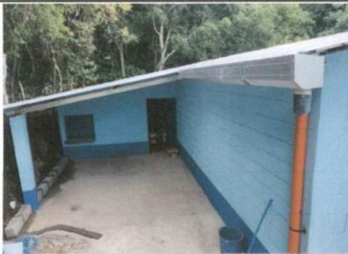
Foto 5: Instalación de canal y bajada de agua pluvial.
