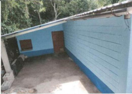
Foto1: Ampliación de lámina troquelada cal. 26
