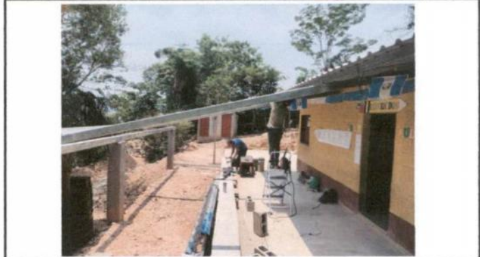
Foto 4: Ampliación de estructura.
