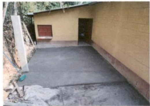
Foto 4: Fundición de terraza de losa de patio.
