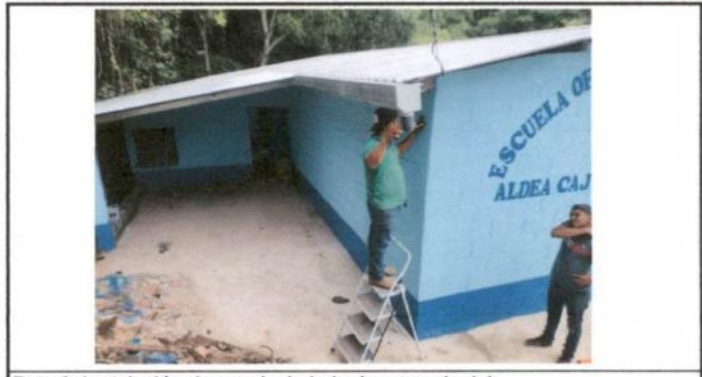
Foto 6: Instalación de canal y bajada de agua pluvial.
