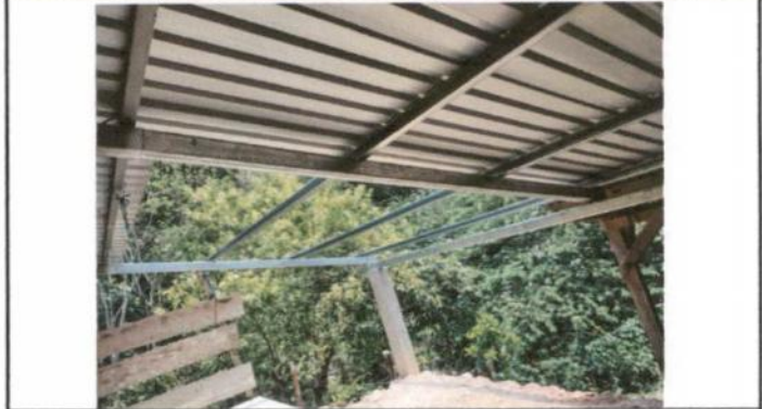
Foto 2: Ampliación de lámina troquelada cal. 26
