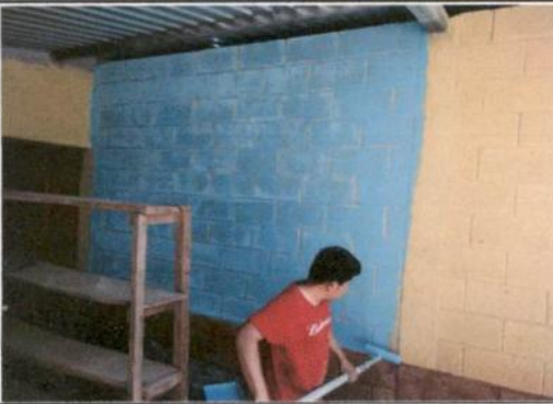
Foto 5: Pintura en paredes del aula, puertas y ventanas
