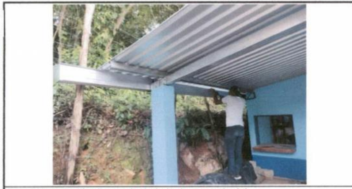
Foto 5: Instalación de canal y bajada de agua pluvial.
