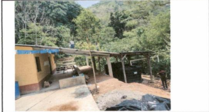
Foto1: Ampliación de lámina troquelada cal. 26
