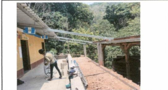
Foto 3: Ampliación de estructura.
