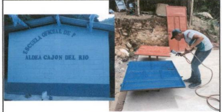
Foto 6: Pintura en paredes del aula, puertas y ventanas
