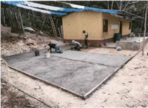
Foto 3: Fundición de terraza de losa de patio.
