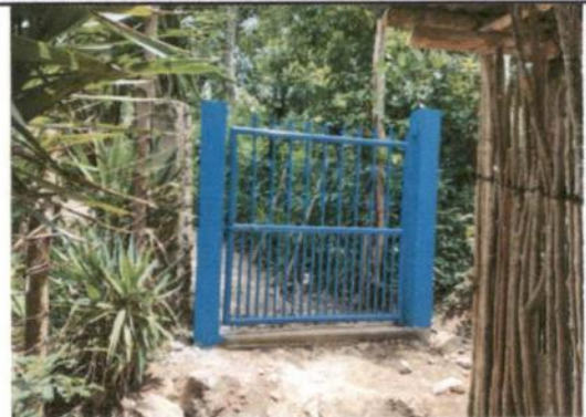
Foto 2: Sustiitución de porton deteriorado, Por Porton nuevo.
