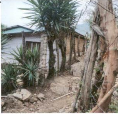
Foto 1: Sustiitución de porton deteriorado, Por Porton nuevo.
