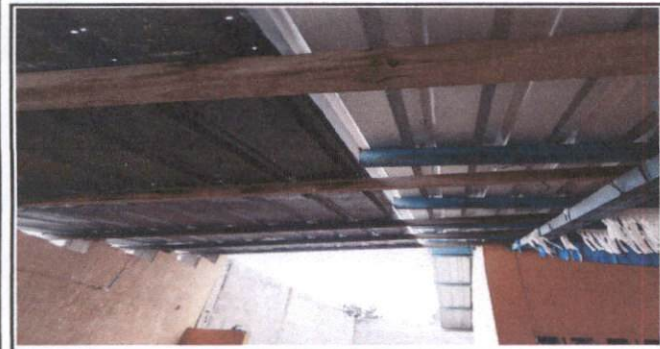
foto 5: Escenario Cambio de techo
