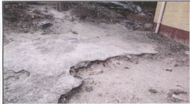
Foto 3: Fundición de Terraza de losa de patio
