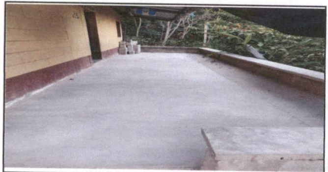
Foto 12: Instalacion de piso ceramico en el corredor
