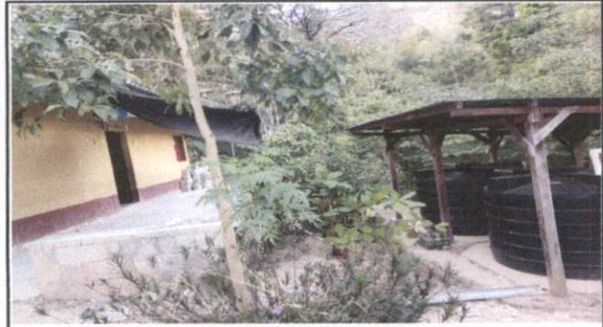
Foto 1: Ampliación de cubierta de lamina
