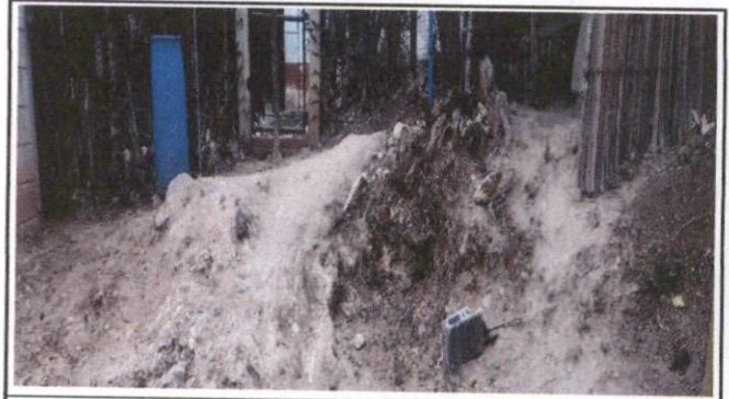
Foto 10: Reparacion e instalación de deposito de agua
