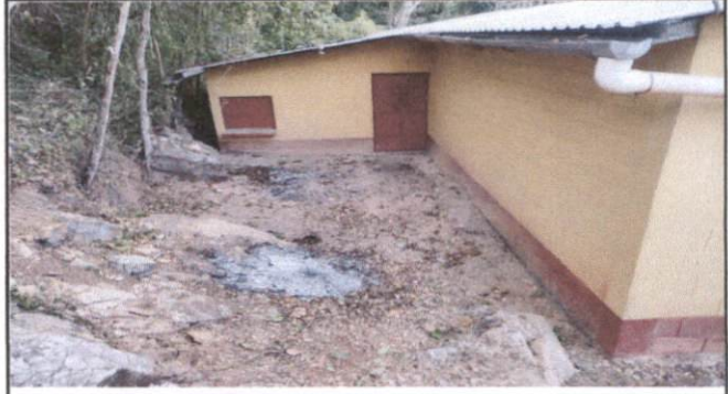
Foto 2: Ampliación de estructura
