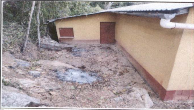
Foto 9: canales y bajadas de aguas pluvial
