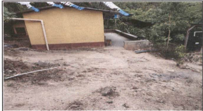
Foto 4: Fundición de losa de patio
