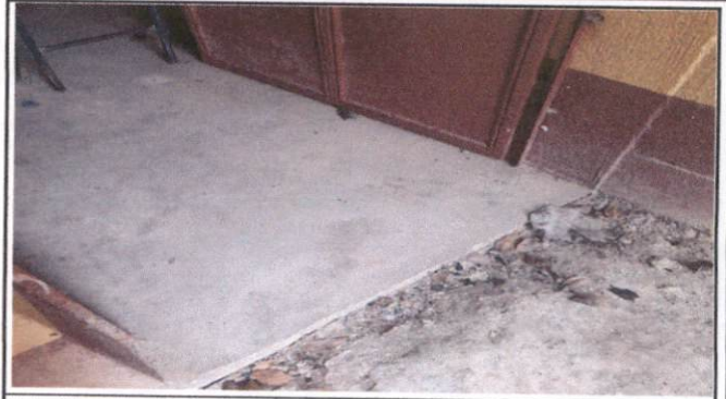
Foto 8: Instalación de piso cerámica
